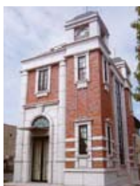
ローンセンター クレオパトラ （水戸市）
